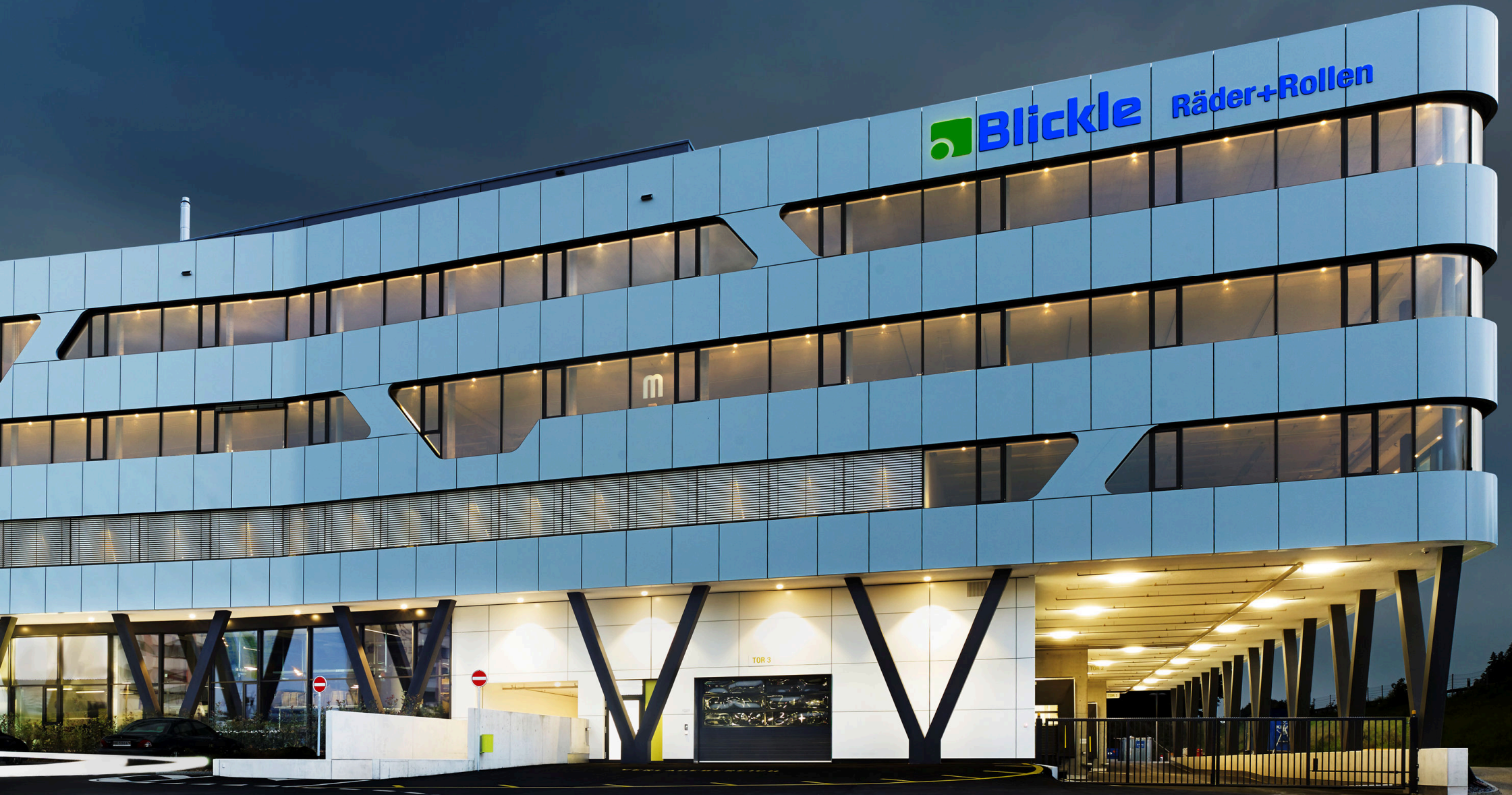
Blickle, Lyssach - Aluverbundkassettenfassade
